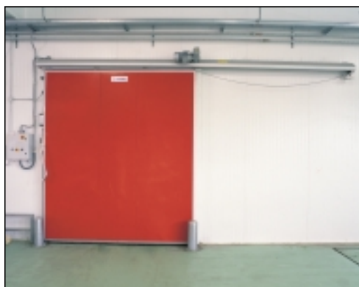
Porte scorrevoli automatiche con colore personalizzato Motorized sliding doors with customized color Automatische Schiebetüren mit kundenspezifischer Farbgebung
