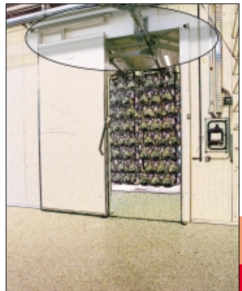
Particolare soluzione passaggio guidovia e collo di cigno Special overhead rail and "swan neck" passage Schiebetür mit Ausschnitt für Hängebahn (Typ Schwanenhals)
